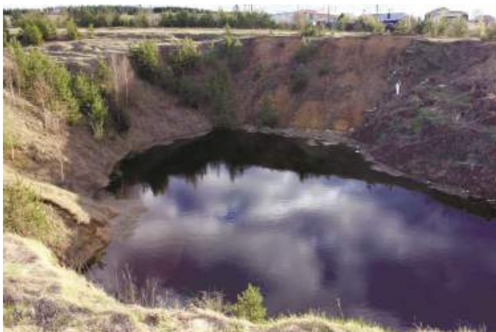
Рис. 1. Провал Николо-Подгорного месторождения по состоянию на 24.05.2017 г. Глубина воды в провале около 3 м.
