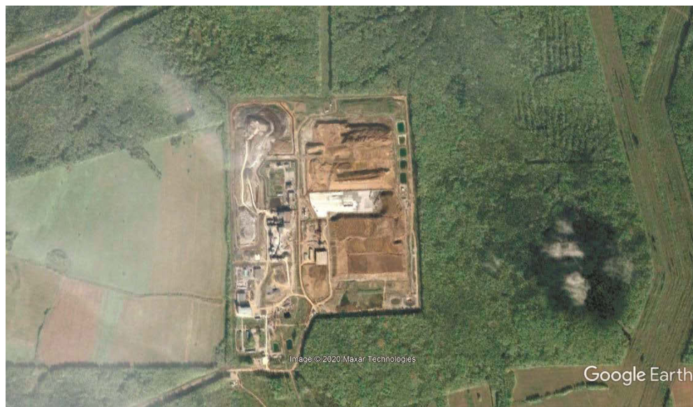
Рис. 2. Производственная инфраструктура на Воронцовском месторождении золота в 2009 г. Fig. 2. Production infrastructure at the Vorontsovskoye gold deposit in 2009
