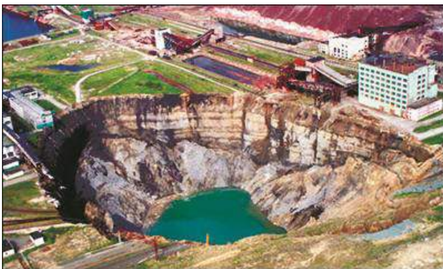
Рис. 1. Провал на Березниковском калийном производственном рудоуправлении № 1 Fig. 1. Soil depression on the territory of the 1st Berezniki potash production group
